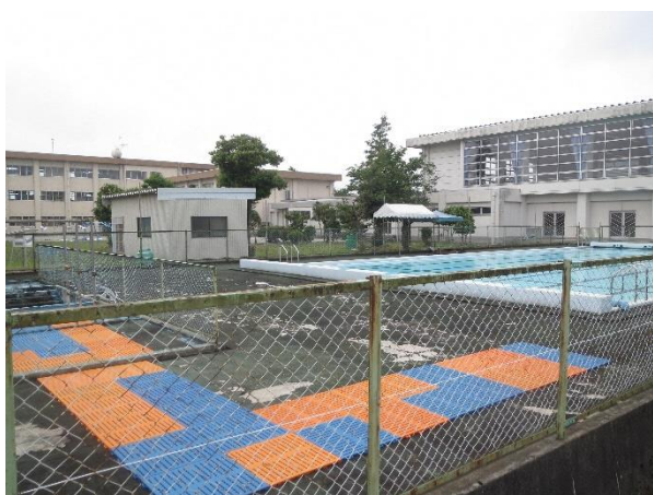
改築予定の朝日小学校プール
